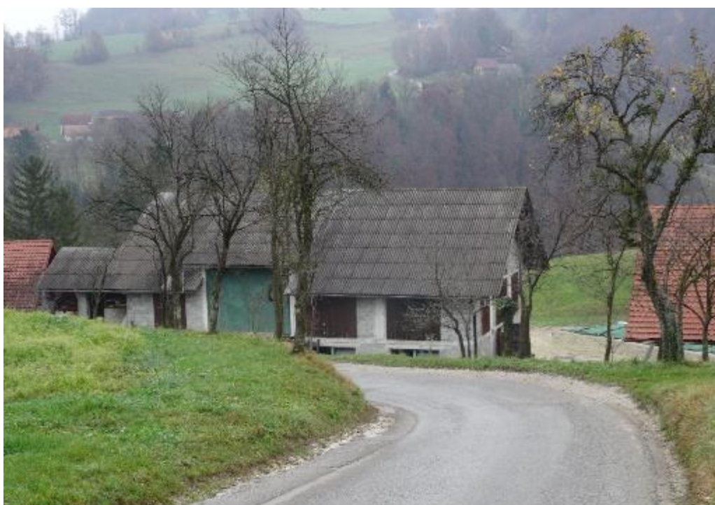
Slika 24: Nevaren odsek št. 3
