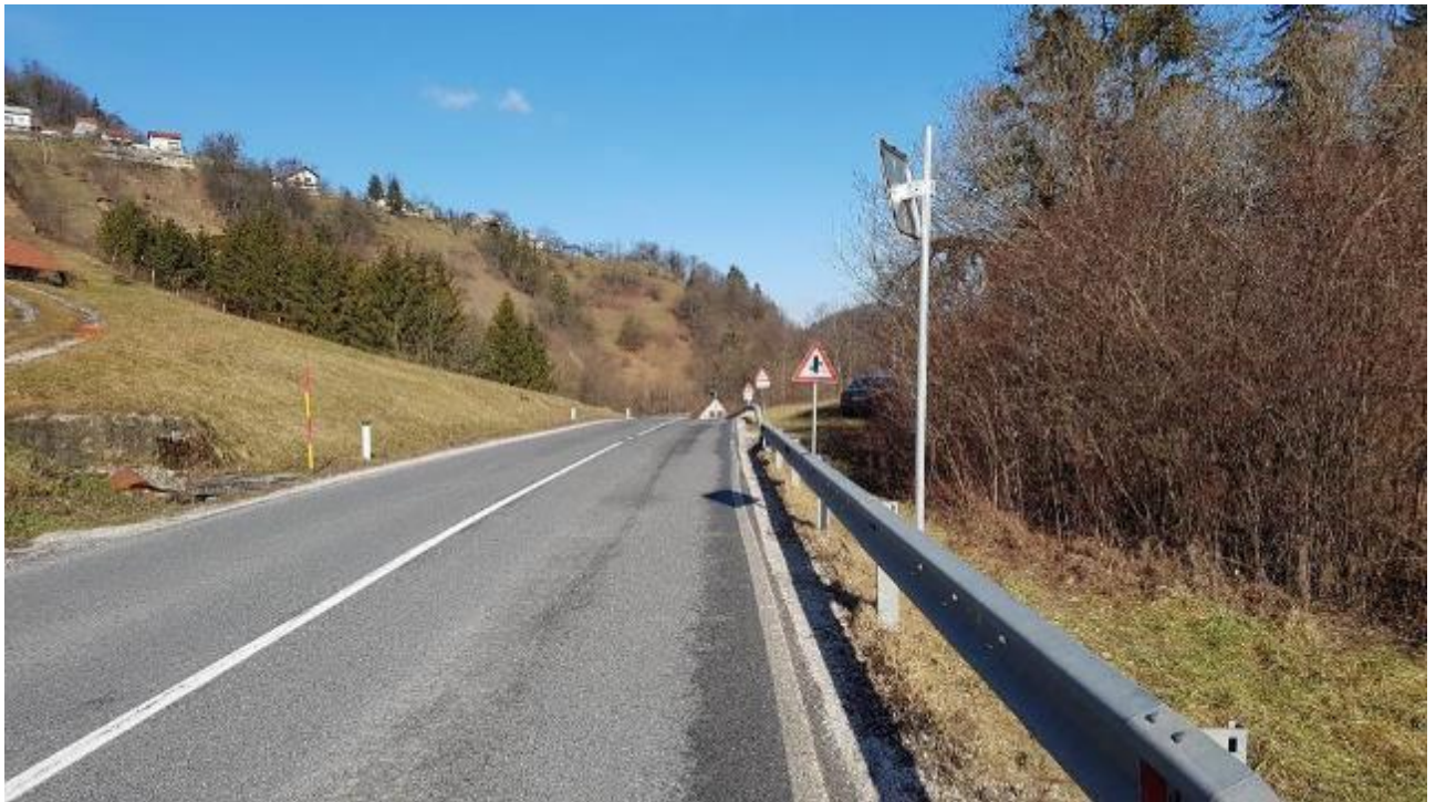
Slika 43: Nevaren odsek št. 15
