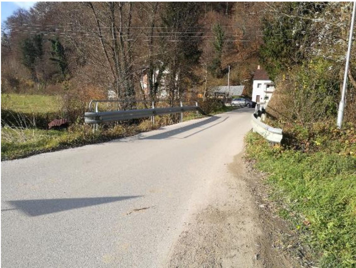
Slika 32: Nevarni odsek št. 8
