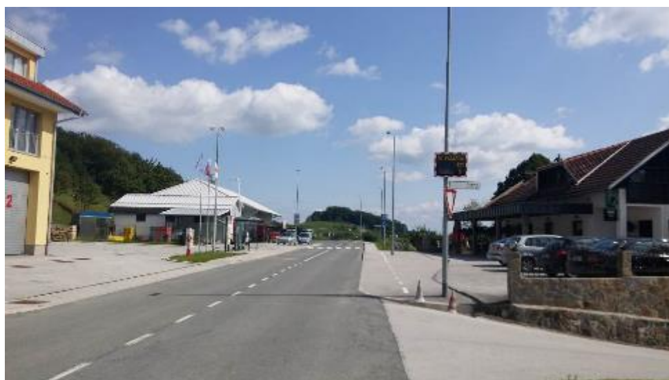
Slika 13: Urejene površine za pešce na cesti skozi Prevorje
