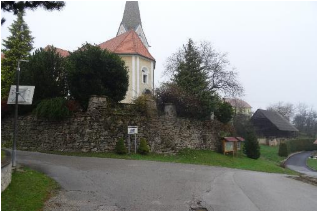
Slika 25: Nevarni odsek št. 4
