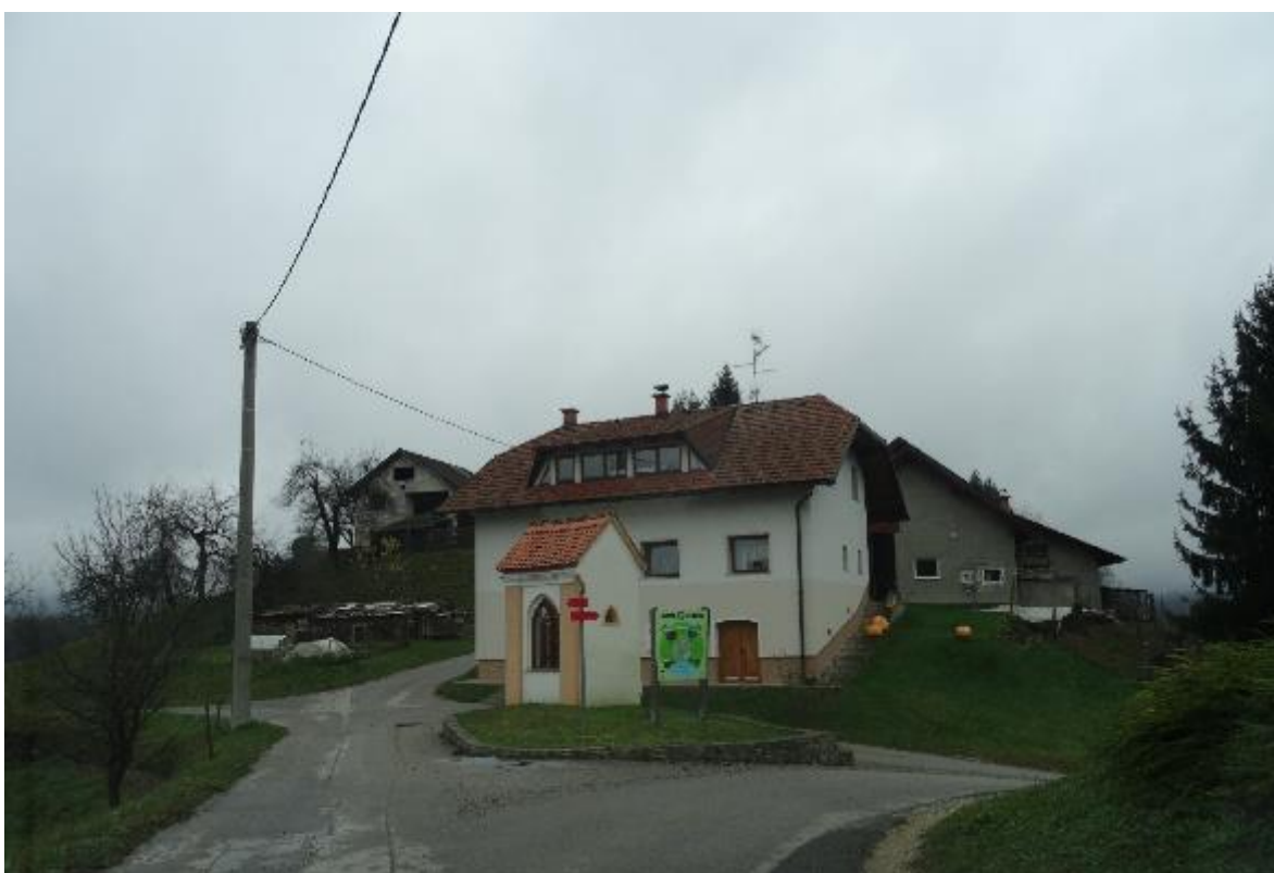
Slika 22: Nevarni odsek št. 2
