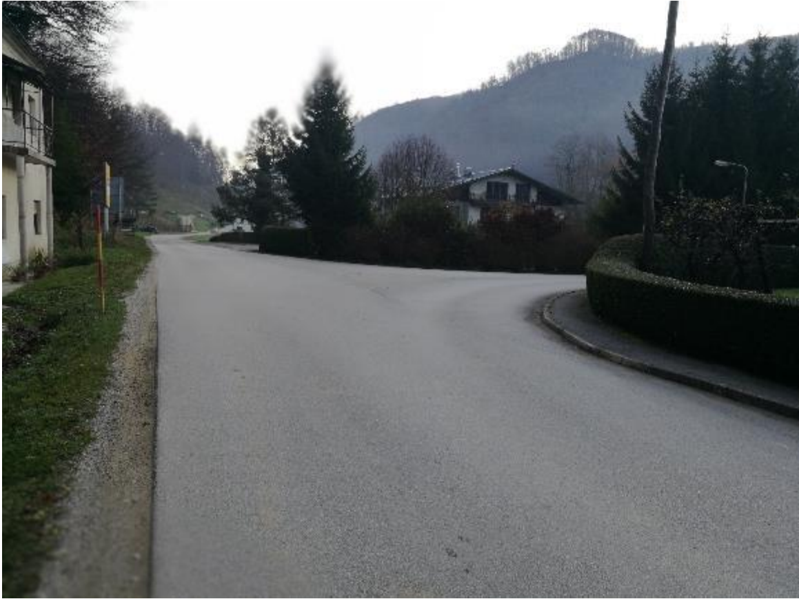
Slika 31: Nevarni odsek št. 7
